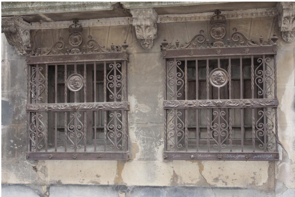
Estado de los elementos metálicos
