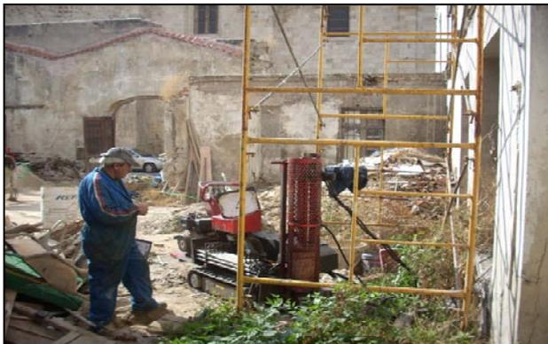
**Emplazamiento del penetrómetro P-4**
